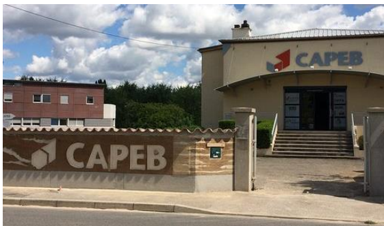
Entrée commune avec la CAPEB
